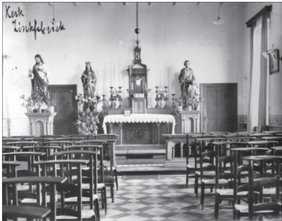
De kapel van de zusters in Hôtel Saint Joseph/de Cantine in Dorplein, opname uit ca. 1900 (met dank aan Bart Maes/ www.weertsisveranderd.nl ).
