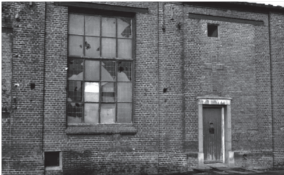
Ingang van de fabriekskapel op de Zinkfabriek vlak vóór de sloop in 1973 (Collectie HistorieKZM, Budel-Dorplein).
