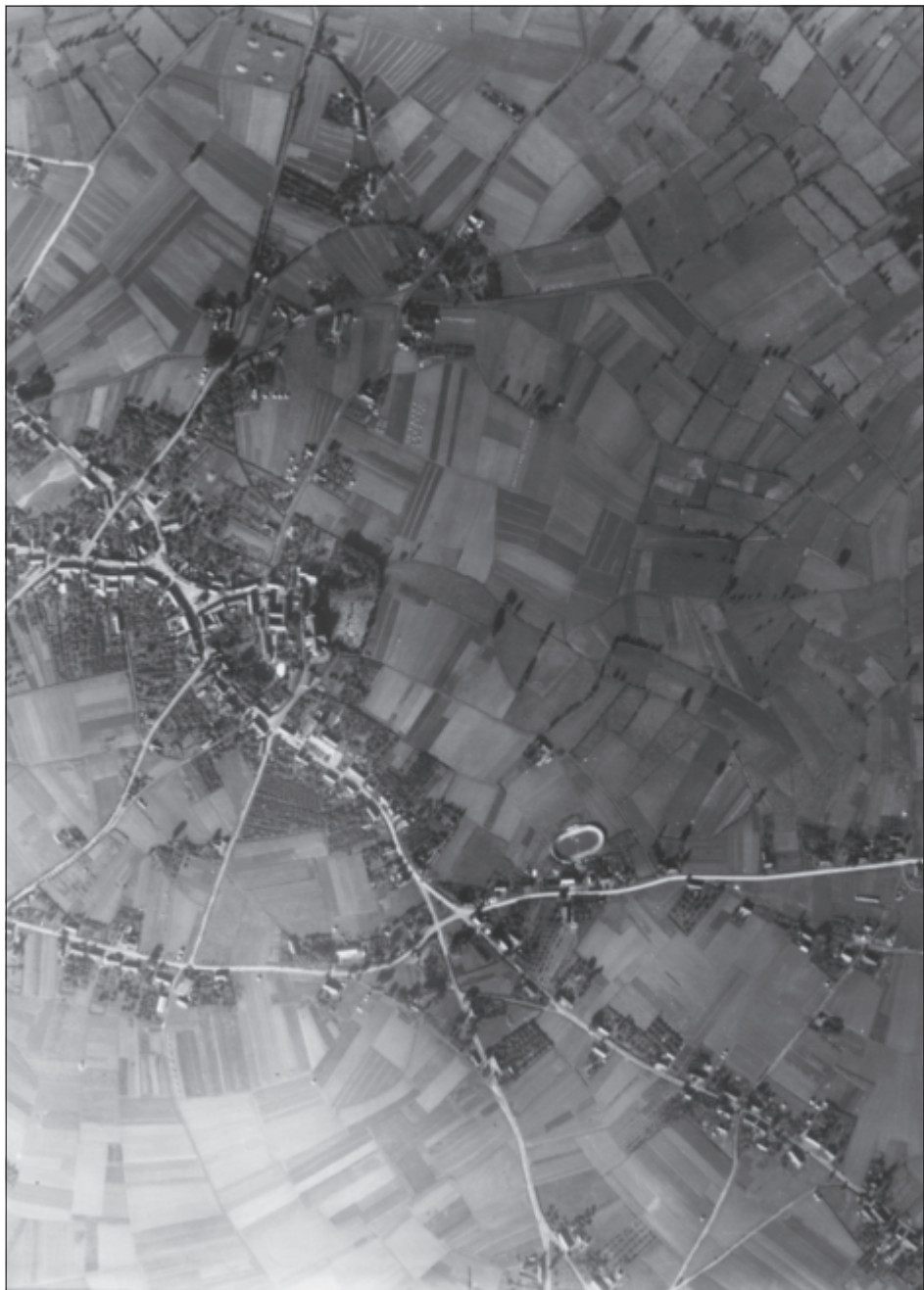
RAF-luchtfoto 3327 van het centrum van Budel, 11 september 1944 (© De auteursrechten en databankenrechten zijn voorbehouden aan het Kadaster, Apeldoorn, 2013 Dotka Data BV).
