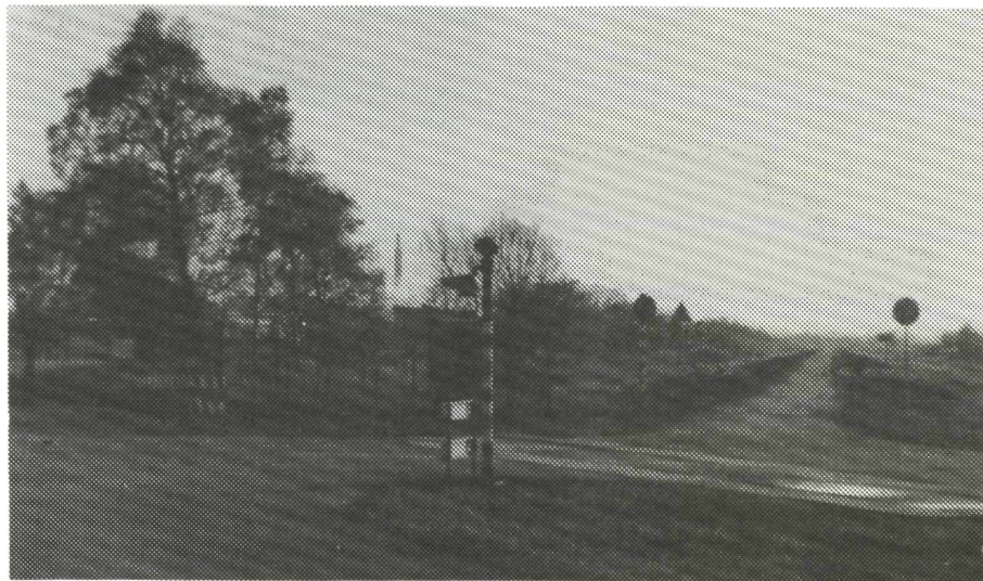
De weegbrug afgebroken
